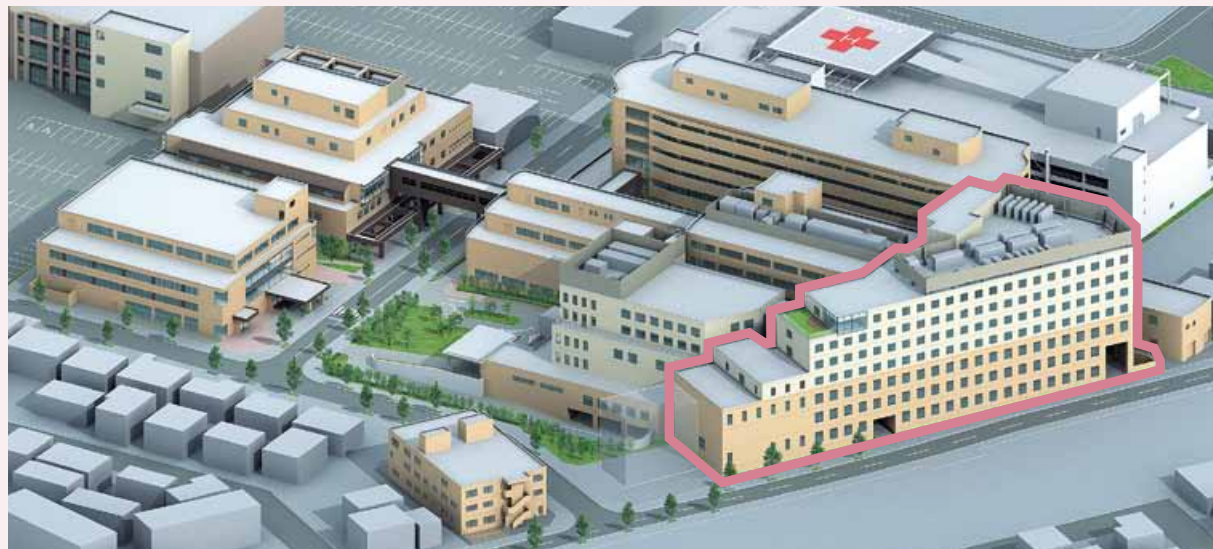
右斜め下のピンク枠の建物が、現在建設中のF棟
