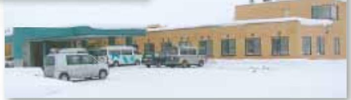
「コミュニティホーム美唄」は、約300トンの雪を冬期間に建物内の貯雪庫に貯蔵し、暑さが厳しくなる7月中旬から8月中旬にかけて、雪の冷熱エネルギーを雪冷房として利用。通所者ダイルム、機能訓練室、事務室などに冷風を送り、快適な環境づくりを図っています。このシステムによって、CO<sub>2</sub>の排出量を大幅に低減できるほか、電気代や冬期の排雪費用の
