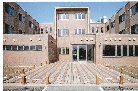
I デッキテラス
