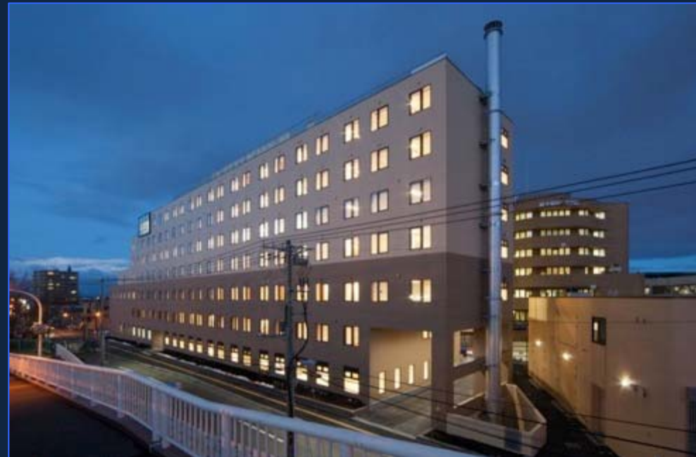
昨年完成した最新病棟(F棟)
